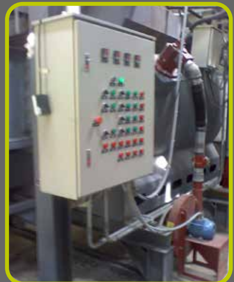
Cámaras de Neutralización
