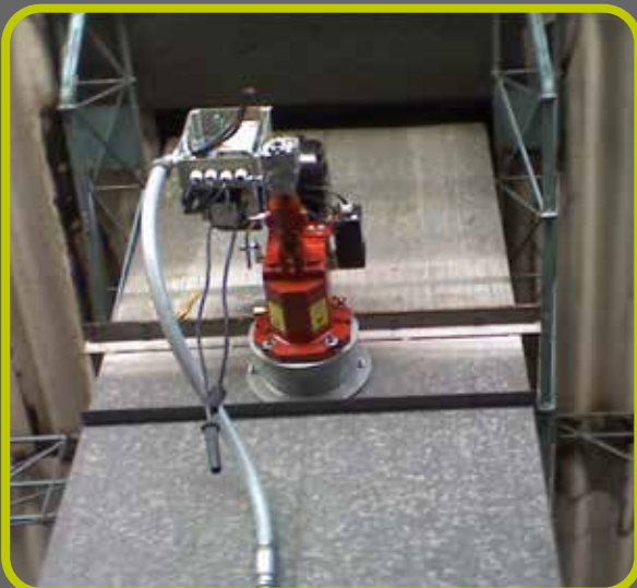
Calentamiento de Aire en Ductos
