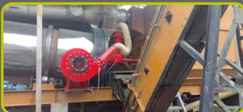
Producción de Asfalto
