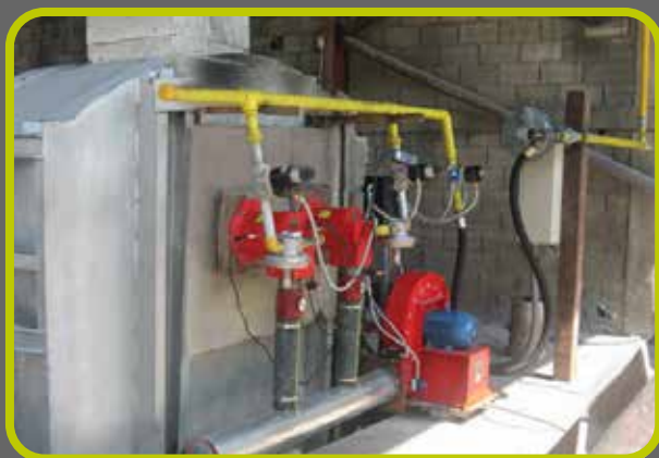
Fundición de Metales
