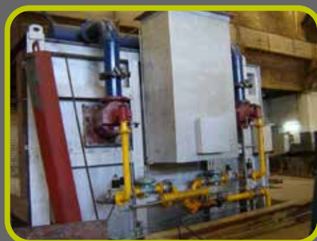
Fundición de Metales Basculante
